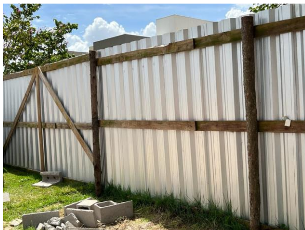
Vista do tapume por dentro da obra
